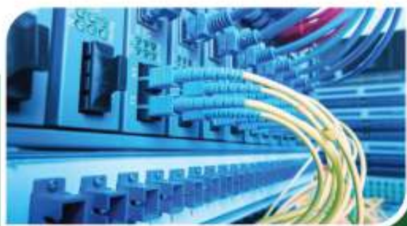
Cung cấp giải pháp và thi công hệ thống điện mạng.
